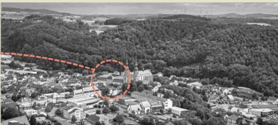
Sanierung des historischen Schulgebäudes
