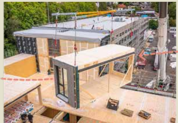
Montage der Module
